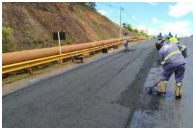
Pavimentação de estrada em parceria com a Anglo American
