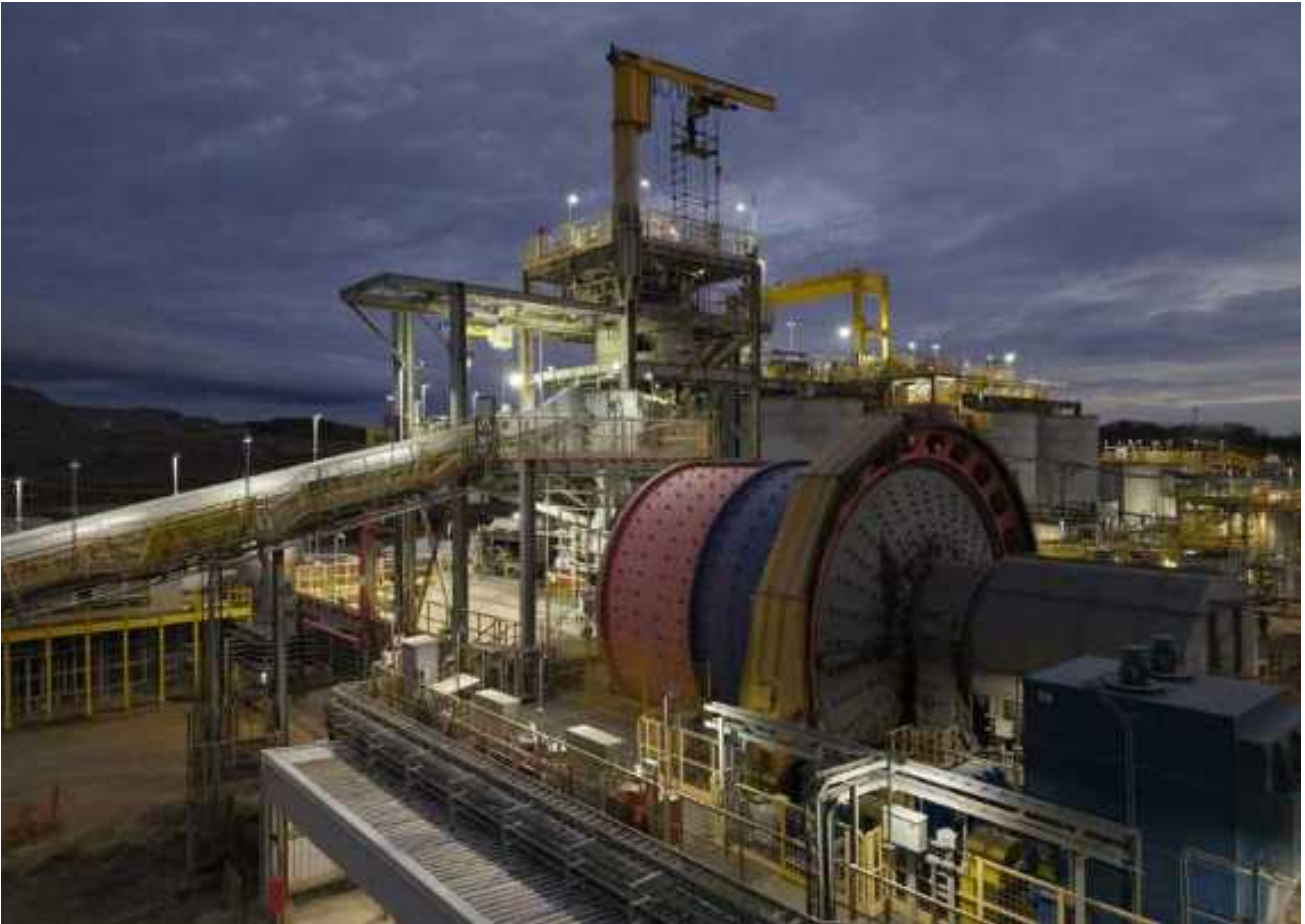
Unidade de moagem na Aura Borborema
