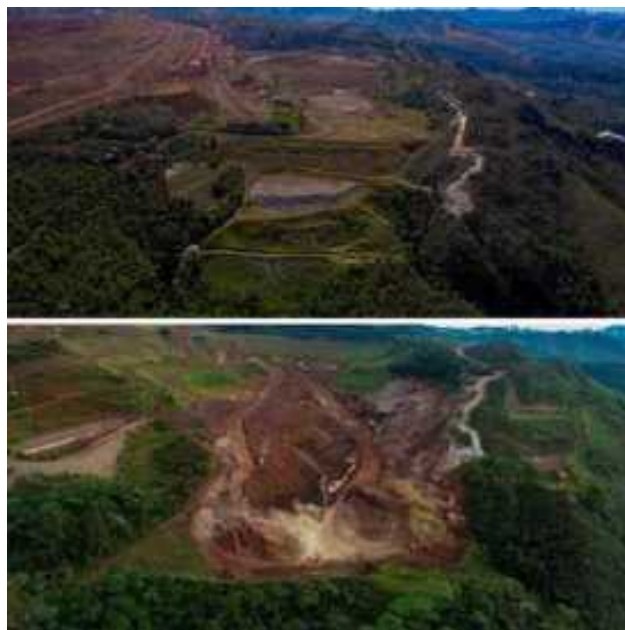
Barragens B3/B4 Antes e depois da descaracterização
