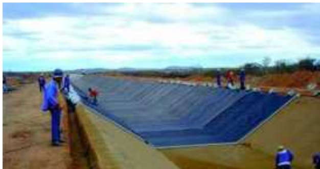
Obra hídrica da Record Engenharia
