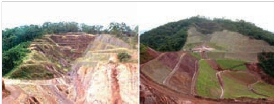
Imagens “antes (2001) e depois (2003)” da reabilitação ambiental em taludes na mina de Caeté
