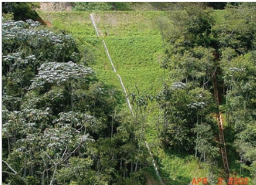
Fase final da recuperação ambiental de voçoroca
