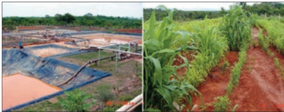
Imagens ANTES: (2001) Tanques de lixiviação, com a Planta em fase final de operação e DEPOIS: (2002) Área toda coberta com material das pilhas lixiviadas e com uma camada de 50 cm de solo para viabilizar a vegetação.
